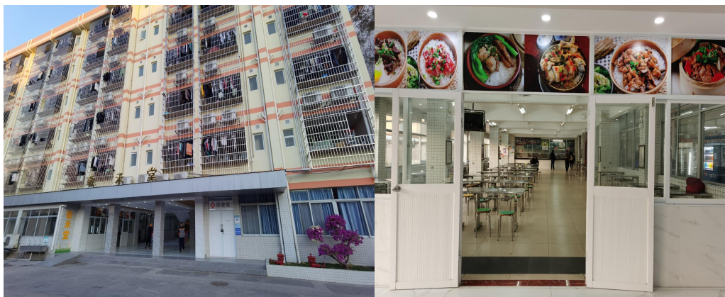
图 3-7、图 3-8 改造后焕然一新的学生宿舍和食堂
